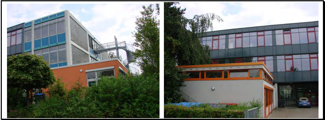
Abbildung 4.2-2: Ansicht Bodelschwingschule; Gebäude Nordost und Nottreppe (li) sowie Südost westlicher Teil (re)
