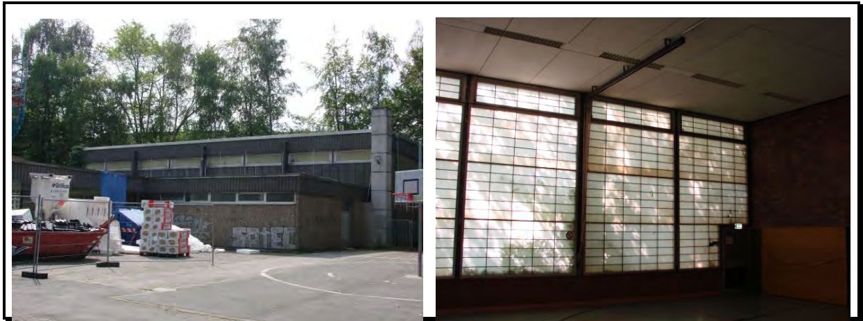
Abbildung 4.1-6: Carl-Orff-Schule: Turnhalle Außenansicht Nordost und Innenansicht Kunststofffassade
