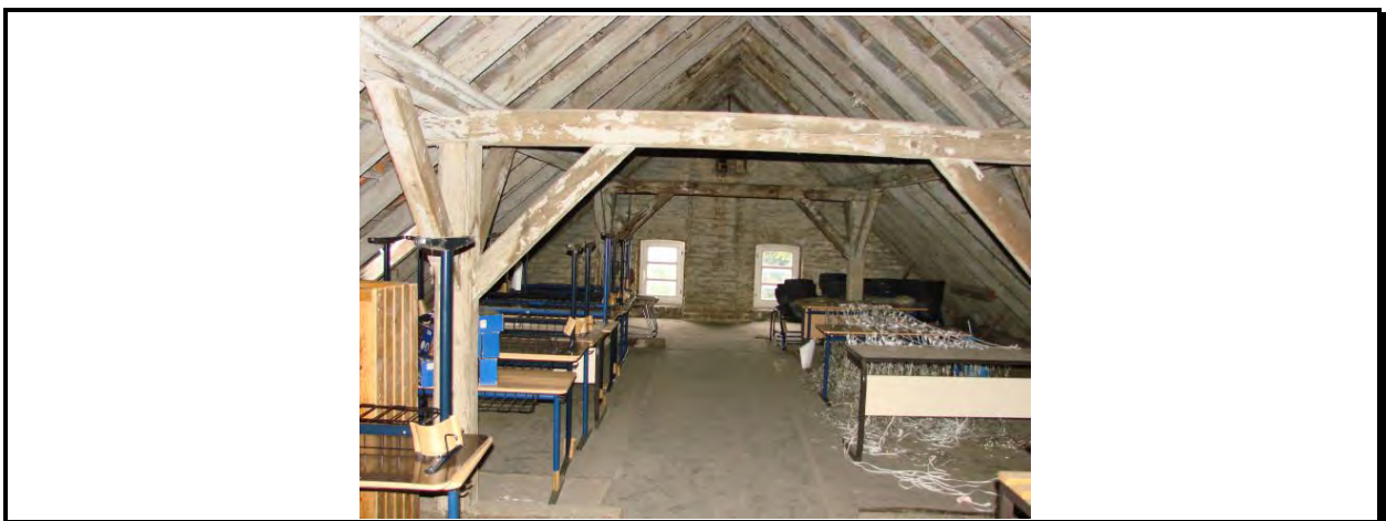
Abbildung 4.7-6: GGS Kendenich: Dachboden
