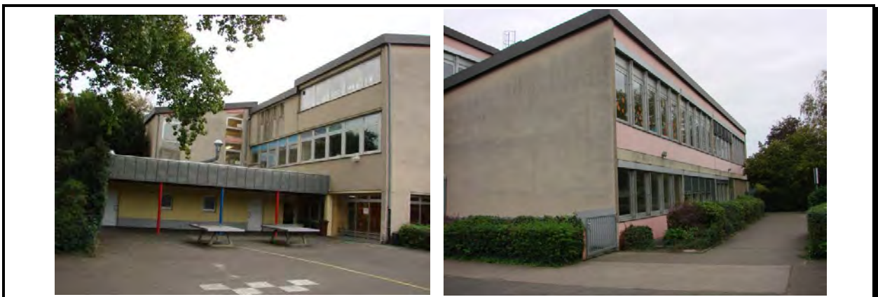
Abbildung 4.6-4: Deutscherrenschule: Bauteil B Außenansicht West (li, mit Außen-WC) und Süd (re)
