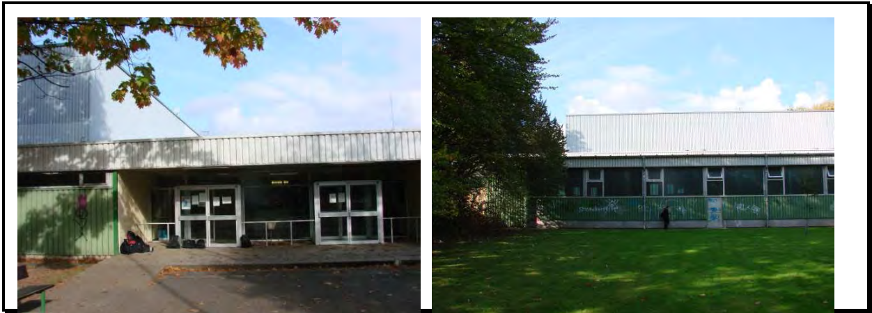
Abbildung 4.10-9: Ernst-Mach-Gymnasium: Außenansicht Sporthalle
