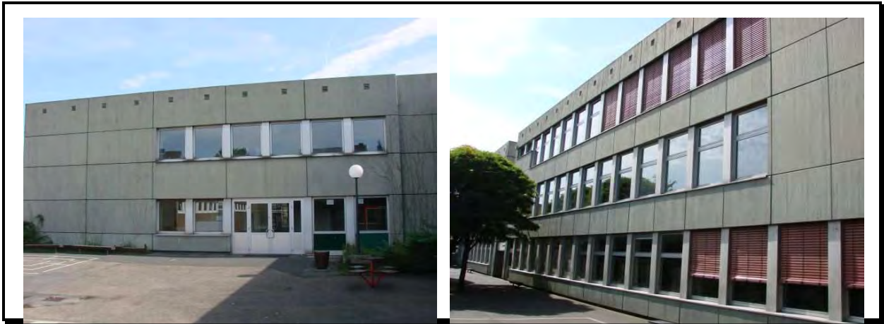
Abbildung 4.8-5: HS Kendenich: Fassade West (li) und Ost (re)
