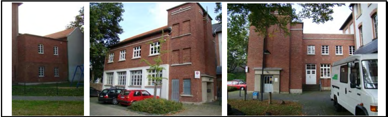
Abbildung 4.13-5: VHS (Alte Schule): Vierter Bauabschnitt von 1929
