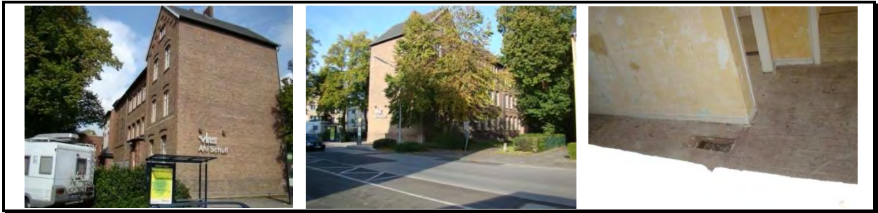
Abbildung 4.13-2: VHS (Alte Schule): Im Vordergrund befindet sich der ursprüngliche Teil der Schule von 1875
