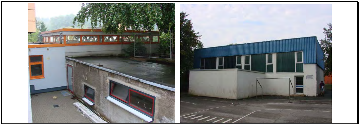
Abbildung 4.2-5: Bodelschwingschule: OGS-Anbau 2005 und Fahrradkeller Außenansicht (li), Turnhalle Außenansicht Nordost (re)
