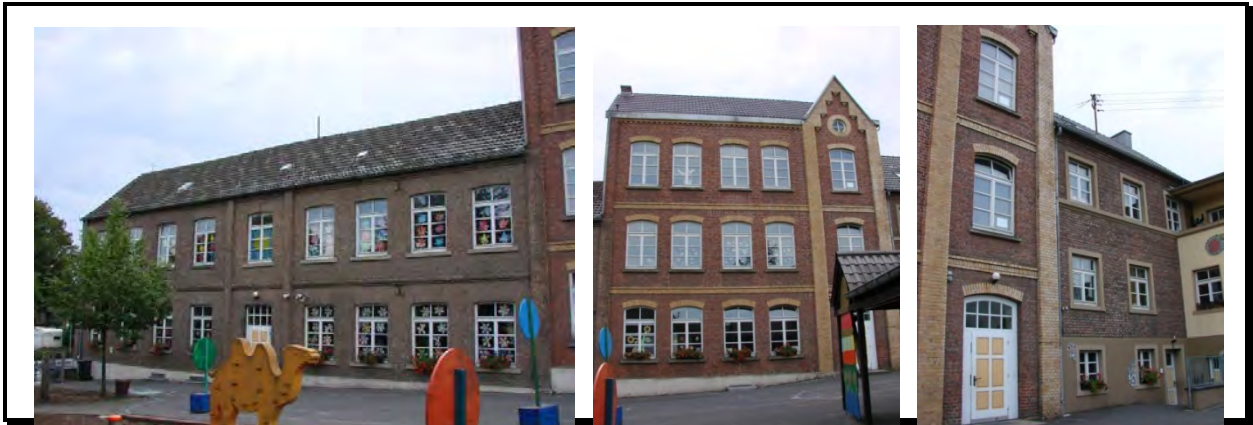
Abbildung 4.7-4: GGS Kendenich: Bauteil 1 (li), Bauteil 2 (Mi) und Bauteil 3 (re)
