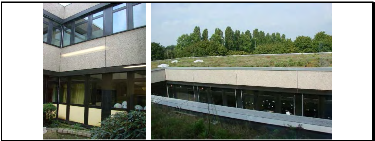
Abbildung 4.11-6: Schulzentrum Sudetenstraße: Fassade Innenhof und begrüntes Dach
