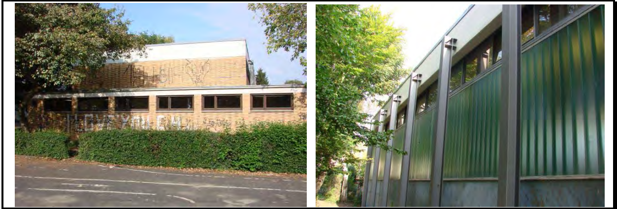
Abbildung 4.5-4: Brüder-Grimm Schule: Turnhalle Südostfassade mit Umkleiden (li) und Südwestfassade mit renovierten Außenträgern. Die Fenster wurden zwischenzeitlich erneuert
