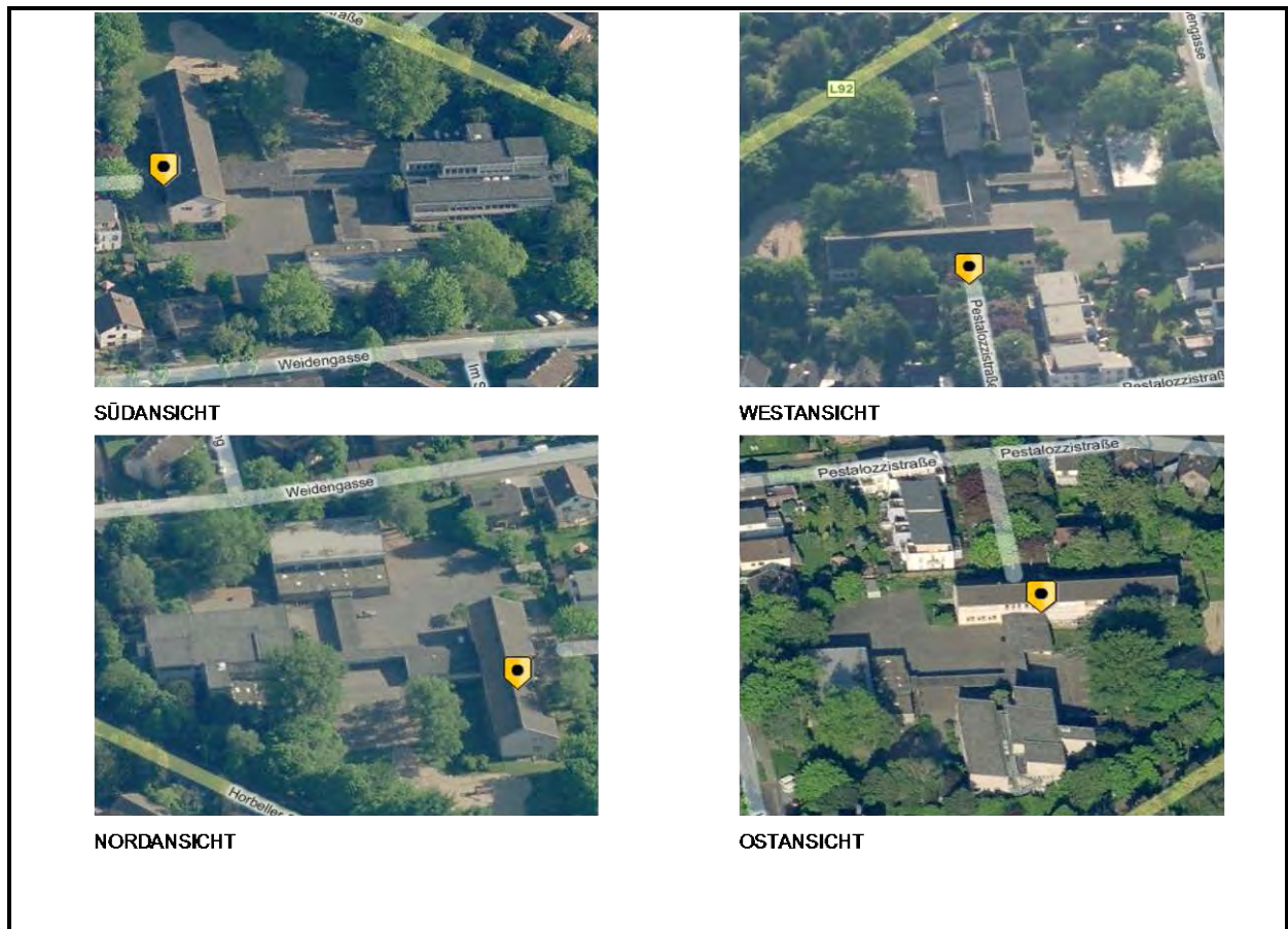
Abbildung 4.6-1: Luftansichten der Deutscherrenschule
