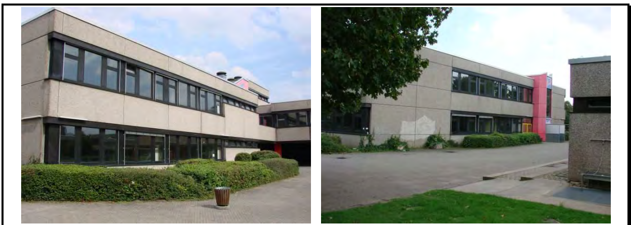
Abbildung 4.11-4: Schulzentrum Sudetenstraße: ASG Fassade Süd-West Bauteil West (li) und Fassade West Bauteil West (re)
