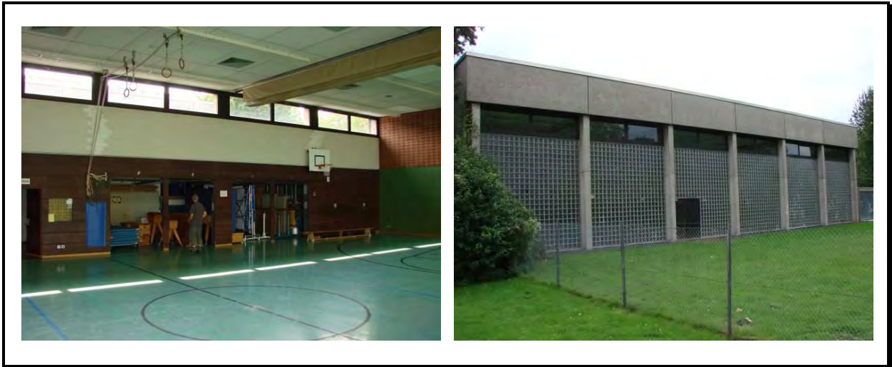
Abbildung 4.11-10: Schulzentrum Sudetenstraße: Kleine Sporthalle mit Glasbausteinfassade
