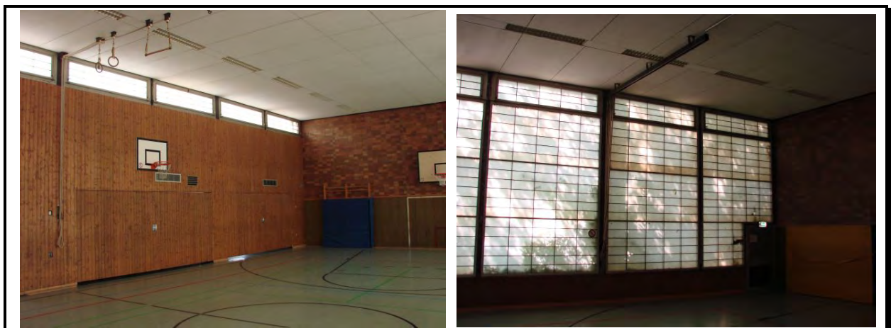
Abbildung 4.1-8: Carl-Orff-Schule: Scobalitifassade der Turnhalle
