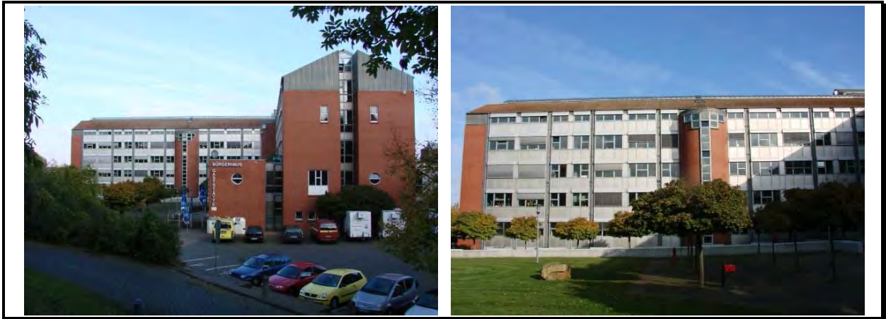
Abbildung 4.14-1: Rathaus: Fassade Süd (li) und West (re)
