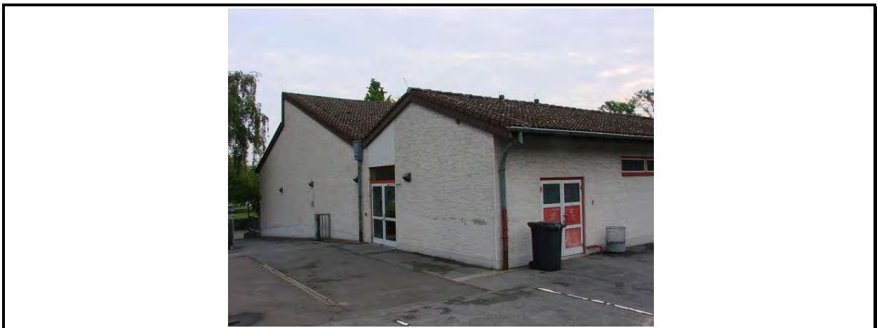
Abbildung 4.3-7: GS Am Clementinenhof: Turnhalle Ansicht Nordwest
