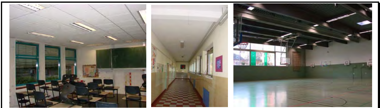
Abbildung 4.9-14: Friedrich-Ebert-Realschule: Beleuchtungsanlagen in Schule und Sporthalle
