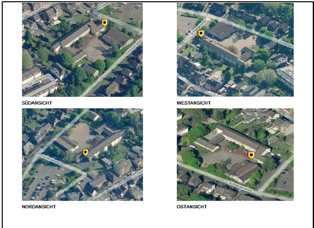
Abbildung 4.3-1: Luftansichten der Grundschule am Clementinenhof
