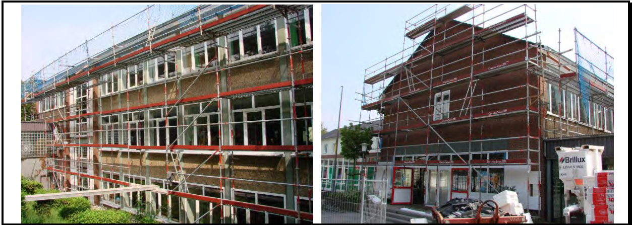
Abbildung 4.1-4: Carl-Orff-Schule: Außenansicht Neubau; Südwest (li) und Nordost (re)
