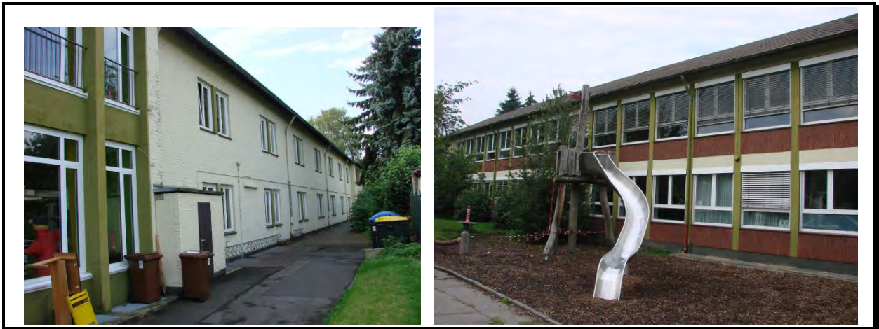
Abbildung 4.3-3: GS Am Clementinenhof: Fassade Nordwest (li) und Südost
