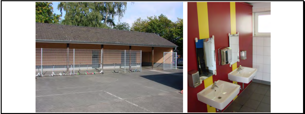
Abbildung 4.4-5 Wendelinusschule: Neue Außentoilette, Außenansicht (li) und Innenansicht (re)
