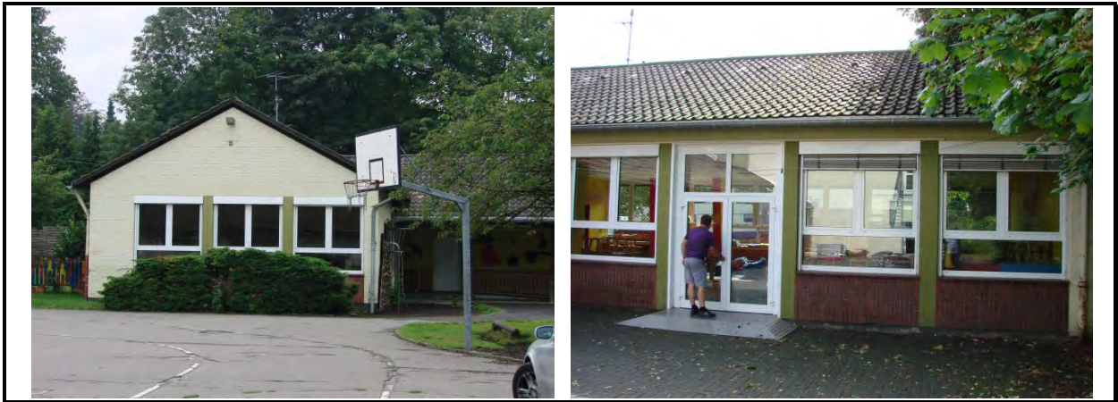
Abbildung 4.3-5: GS Am Clementinenhof: OGS Anbau Ansicht Nordost (li) und Nordwest (re)
