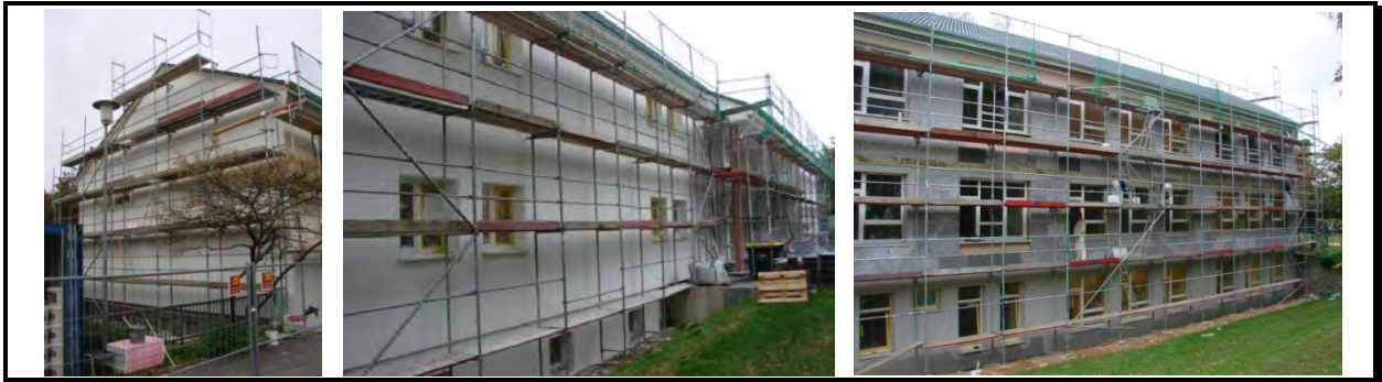
Abbildung 4.6-2: Deutscherrenschule: Bauteil A eingerüstet Ansicht Süd (li), West (Mi) und Ost (re)
