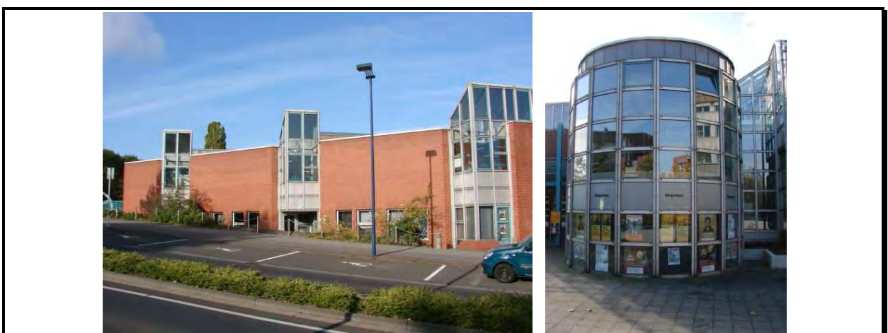
Abbildung 4.14-5: Bürgerhaus: Fassade Süd-Ost (li) Treppenhaus (re)
