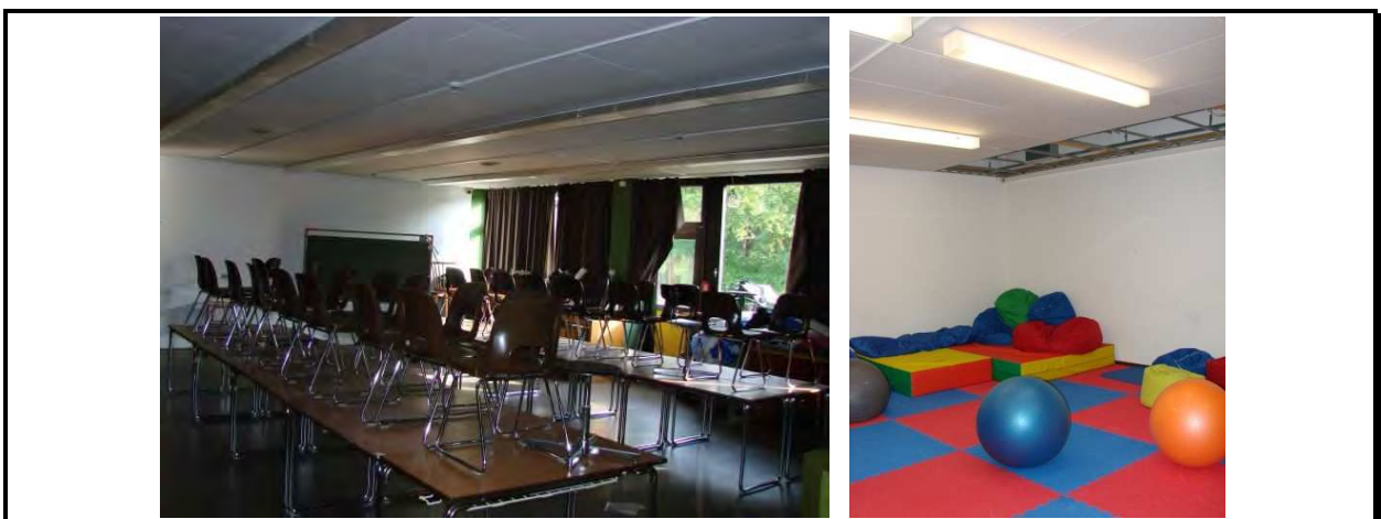
Abbildung 4.11-12: Schulzentrum Sudetenstraße: Alte Lichttechnik z.B. Kunstraum (li) Ruheraum (re)
