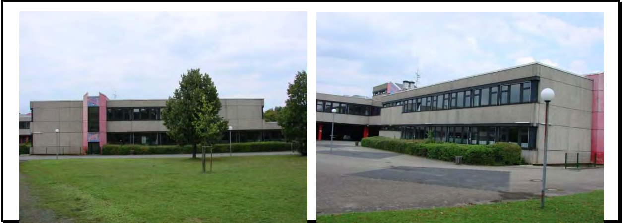
Abbildung 4.11-5: Schulzentrum Sudetenstraße: HS-Fassade Süd-Ost Bauteil Süd-Ost (li) und HS Fassade Süd-West Bauteil Süd-Ost
