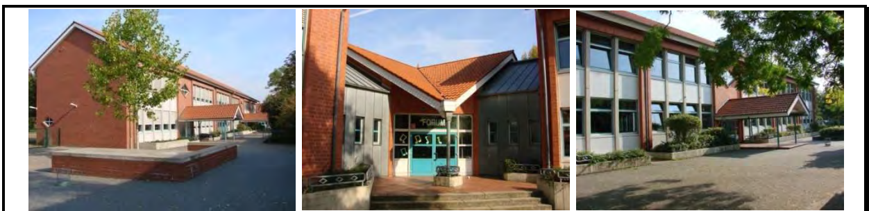
Abbildung 4.9-6: Friedrich-Ebert-Realschule: Bauteil C (li), Forum (Mi) und Bauteil D (re)
