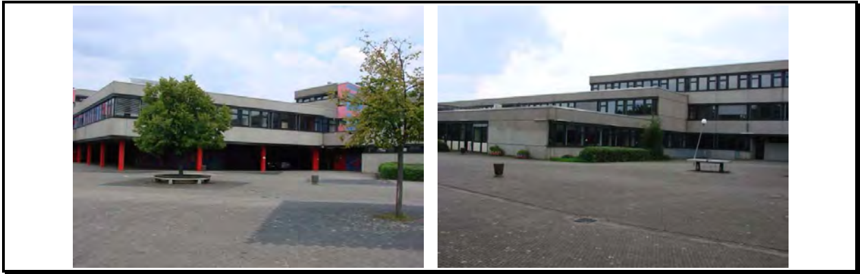
Abbildung 4.11-2: Schulzentrum Sudetenstraße: ASG-HS-Mittelbauteil PZ Fassade Süd-West und Süd-Ost (li) und Bauteil Ost
