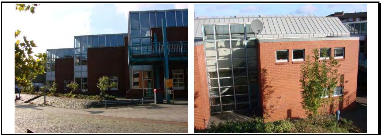
Abbildung 4.14-4: Bürgerhaus: Fassade Nord und Ost (li) und Süd (re)
