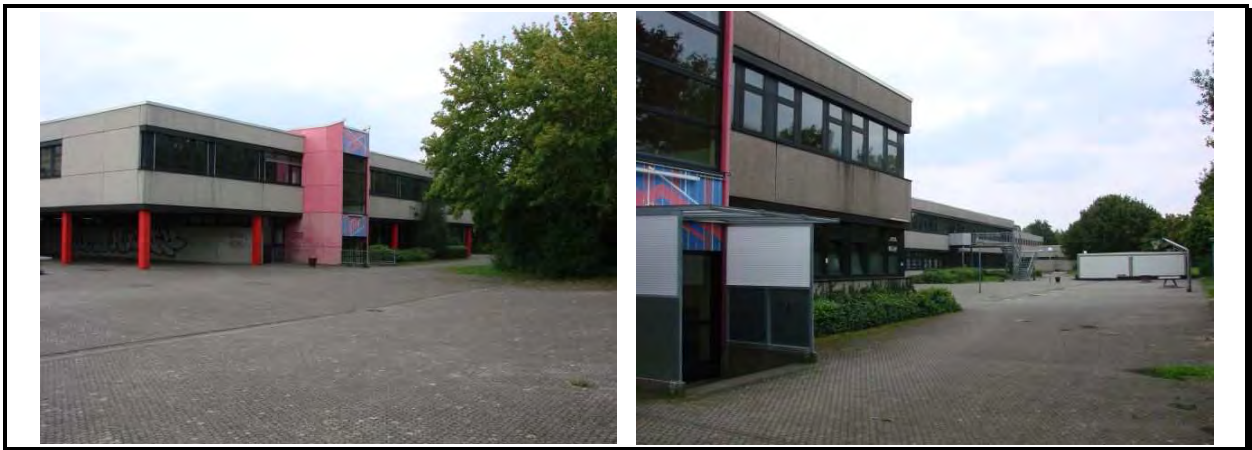
Abbildung 4.11-3: Schulzentrum Sudetenstraße: ASG Eingang Nord-Ost (li) und Fassade Nord-West (re)
