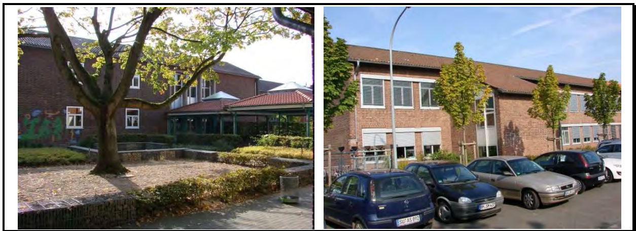
Abbildung 4.9-8: Friedrich-Ebert-Realschule: Bauteil E Nord- (li) und Südseite (re)
