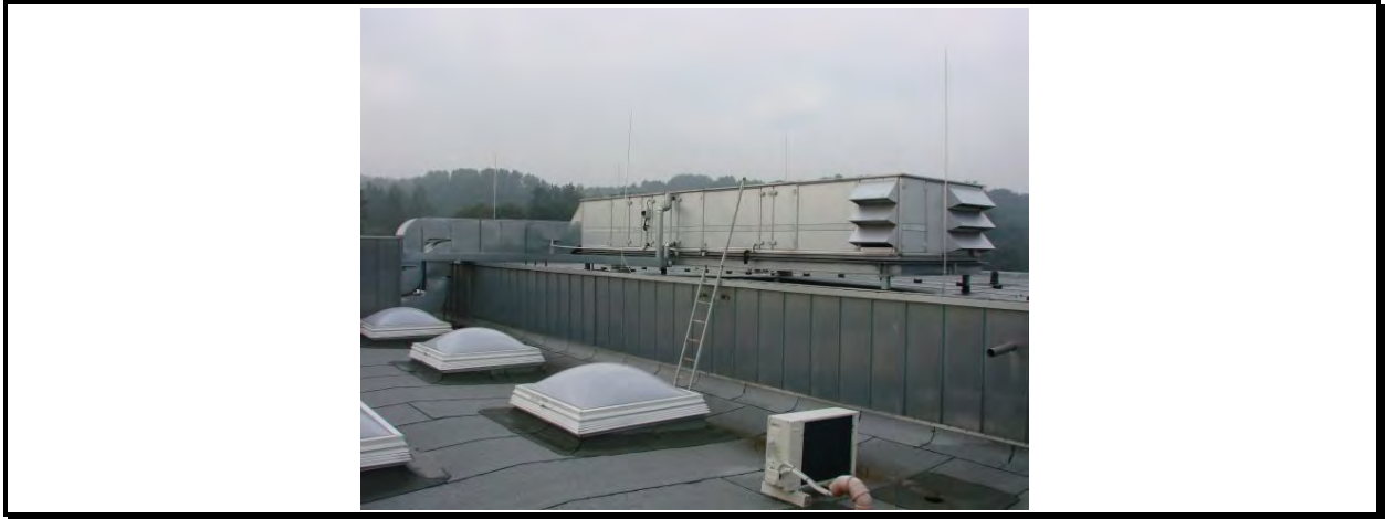
Abbildung 4.2-7: Hauptgebäude Bodelschwingschule: Dach und Lüftungsanlagen
