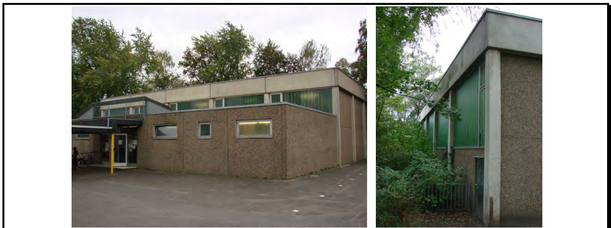
Abbildung 4.6-6: Deutscherrenschule: Turnhalle Außenansicht Nord (li) und Süd (re)
