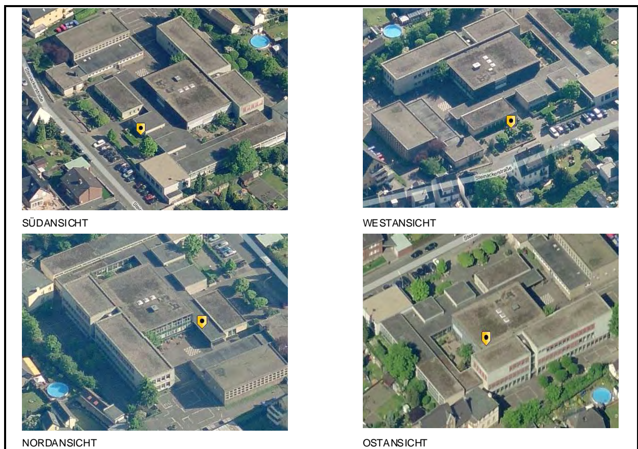
Abbildung 4.8-1: Luftansichten der HS Kendenich
