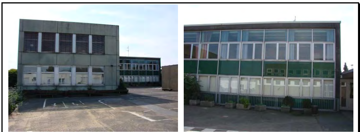
Abbildung 4.8-4: HS Kendenich: Fassade Nord
