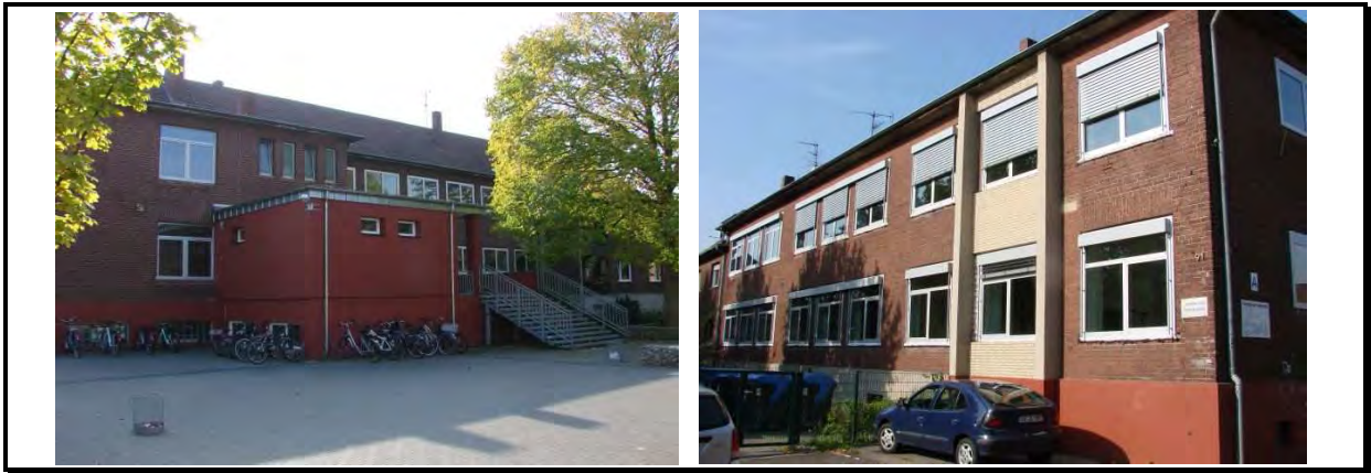
Abbildung 4.9-2: Friedrich-Ebert-Realschule: Bauteil A Nordseite mit neuem WC und Südseite
