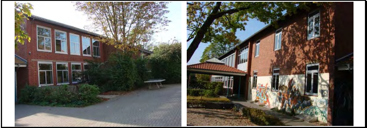
Abbildung 4.9-4: Friedrich-Ebert-Realschule: Bauteil B Nord (li) und Südseite(re)
